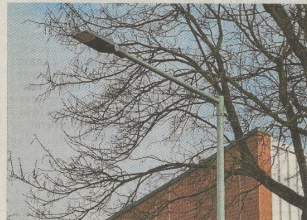
Ein intelligentes Lichtsystem ermöglicht das Training auf der Tartanbahn auch bei Dunkelheit. Es leuchten jeweils nur die LED-Lampen, in deren Einzugsbereich sich gerade ein Läufer befindet.
