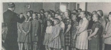
Bei der Einweihung des neuen Realschulgebäudes im Jahre 1956 wurde eifrig gesungen. Viele solcher historischen Fotos finden sich in der Festschrift.
