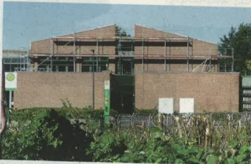
Das Schulzentrum von Bad Wünnenberg wird aktuell energetisch saniert.
