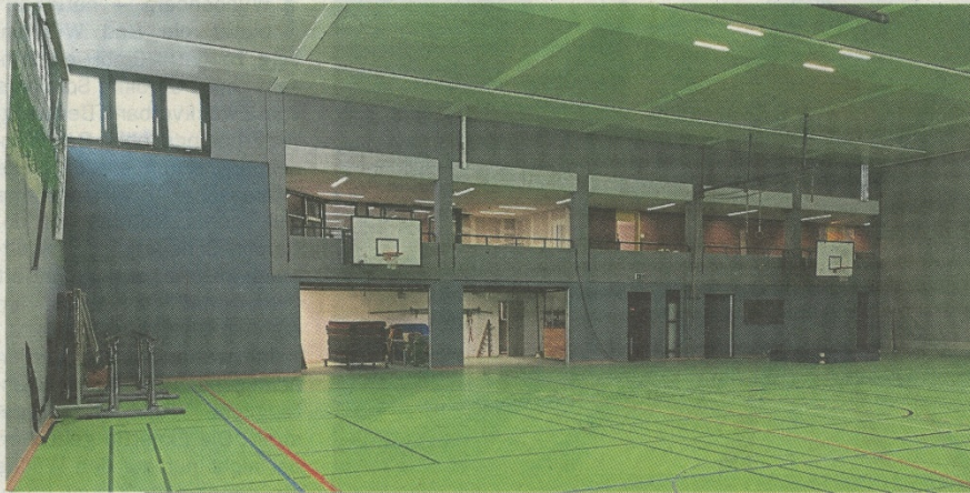
Die Dreifachturnhalle des Schulzentrums in Fürstenberg ist energetisch saniert worden. Seit Februar kann sie wieder genutzt werden.
